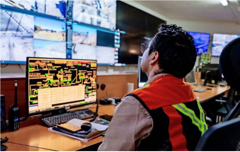
Centro de Control Remoto Operaciones Lomas Bayas.
