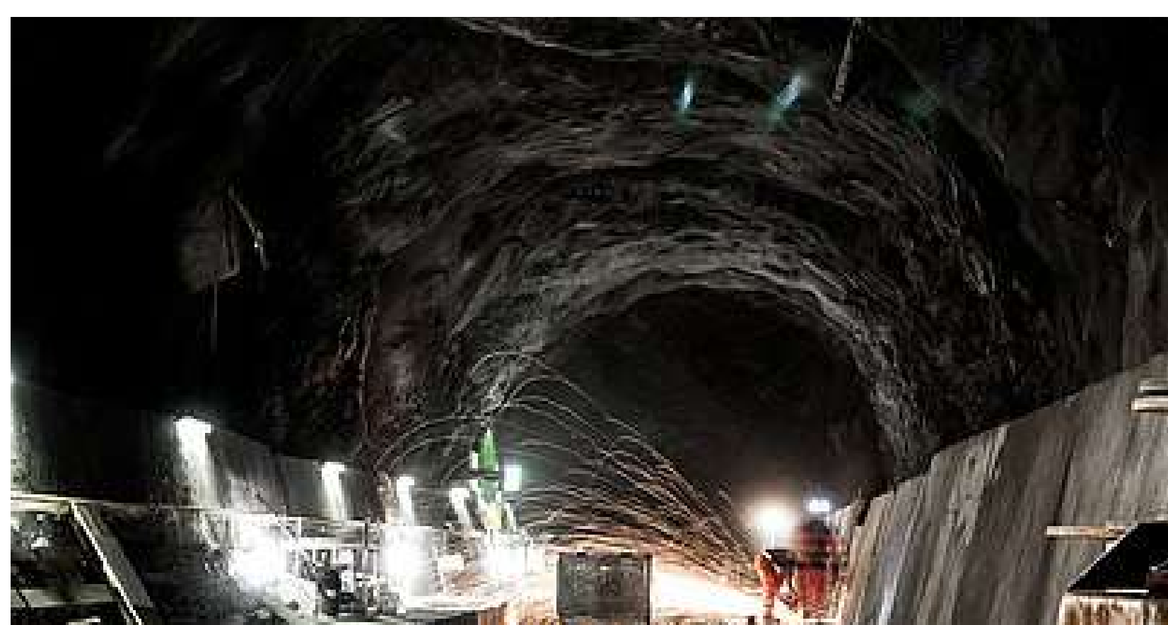
Underground Future Lab - Centro de innovación de relevancia nacional que lidera la digitalización de túneles
